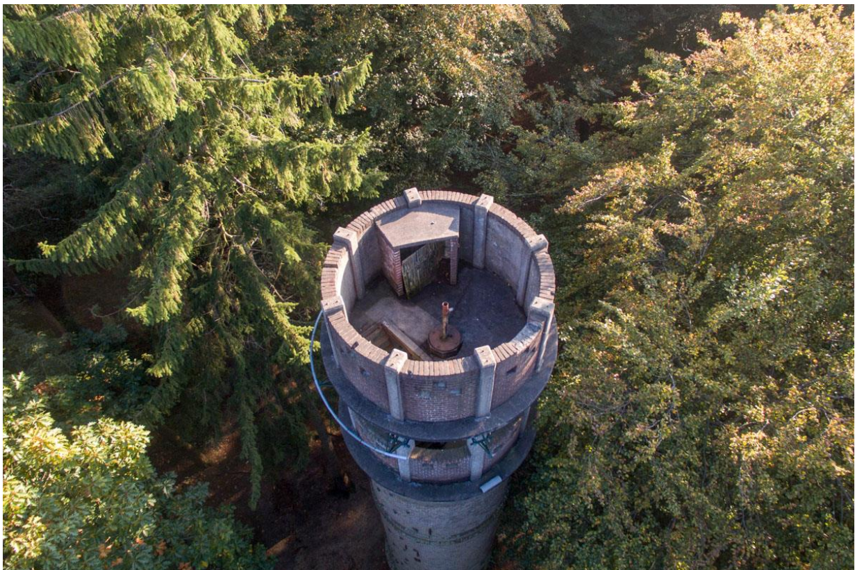
Bovenste verdieping met statief van het peiltoestel en schuilhokje
